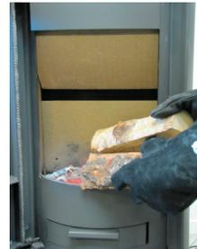
Normalerweise sollten Sie die Ofentür auf den ersten 2-3 Zentimetern langsam öffnen und dann abwarten, bis der Druck ausgeglichen ist, bevor Sie die Tür ganz öffnen. Auf diese Weise vermeiden Sie Rauchbelästigung, insbesondere in Verbindung mit schlechtem Schornsteinzug.
